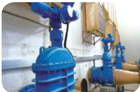
水資源管理弁の交換
