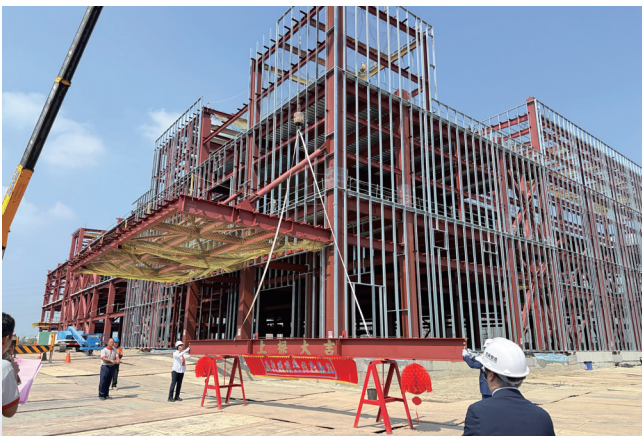
2025.10.16 台湾荏原台南第二工場の上棟
