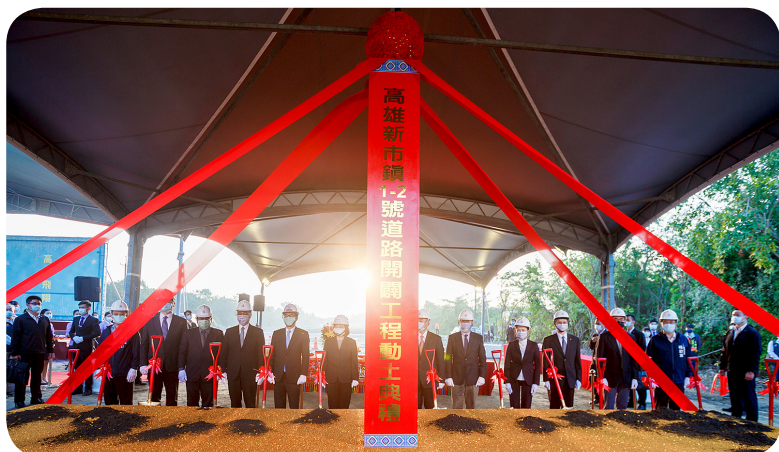
「高雄新市鎮1-2號道路開闢工程」動土典禮 (2021.12.24)
