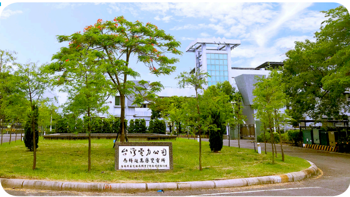
南科超高壓變電所
