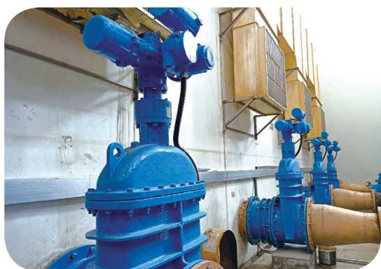
制水閥更新汰換
