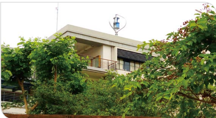
綠能科技-垂直式風力發電系統建置完成(105.10.23)
