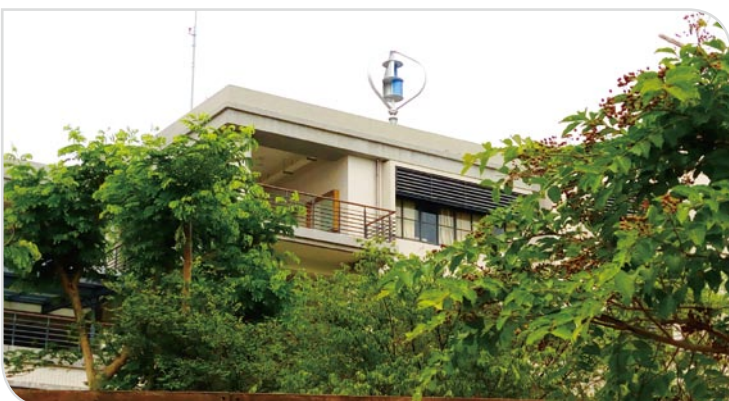
グリーンエネルギーテクノロジー-垂直式風力発電システムの建設が完了(2016.10.23)
