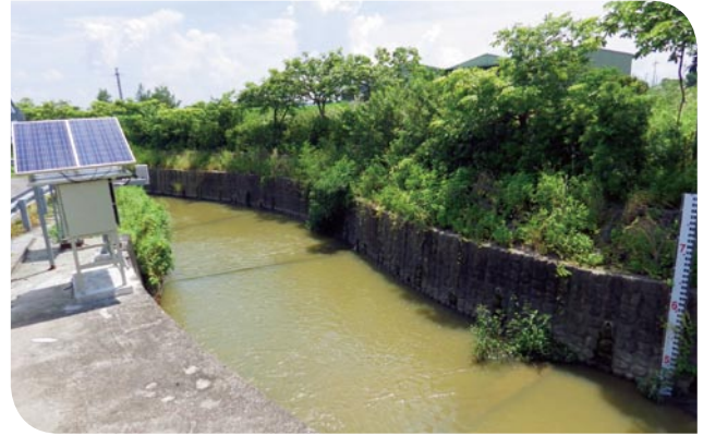
■ 水位モニタリング施設
