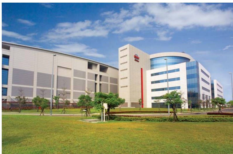
南科積體電路、光電聚落已有相當基礎，圖為台南園區台積電十四廠。
