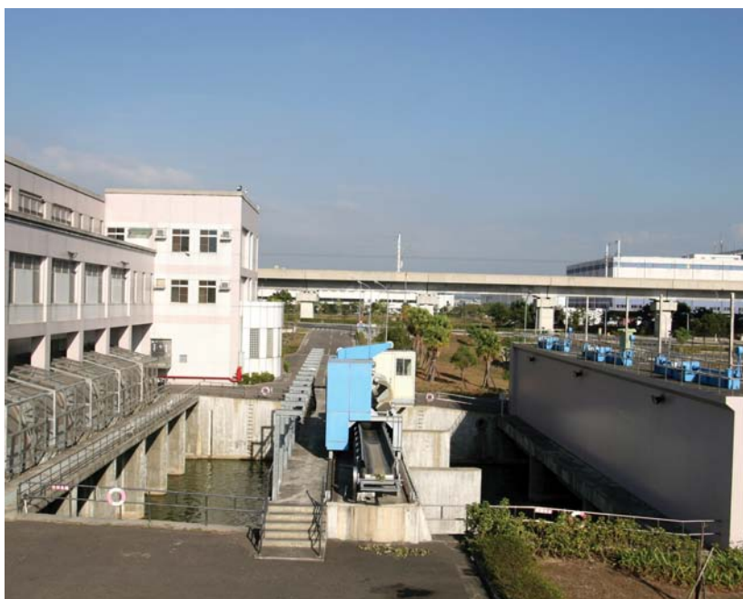
抽水站的建置，使台南園區的防汛功能顯著提升。
