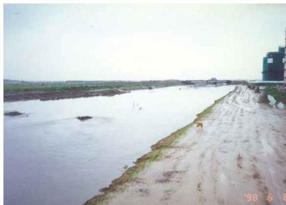
台南園區古早大洲排水（有眷宿舍旁）。
