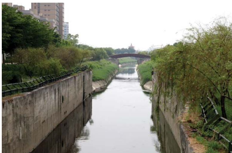
台南園區大洲排水整治工程完工後景象。
