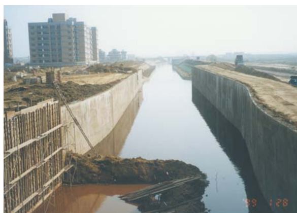
台南園區大洲排水整治工程進入綠化階段。
