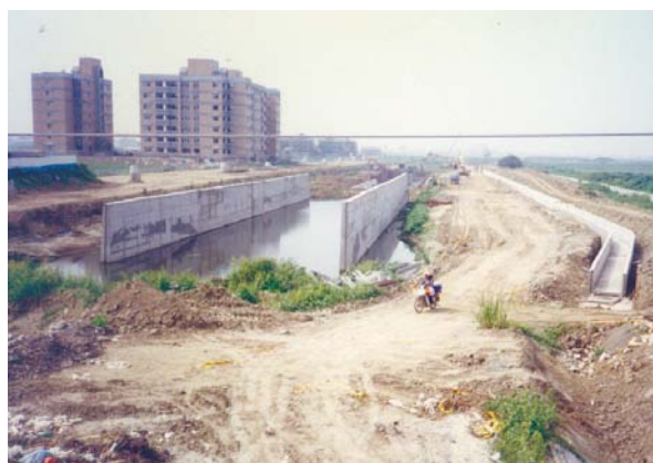
台南園區大洲排水整治工程中景象。
