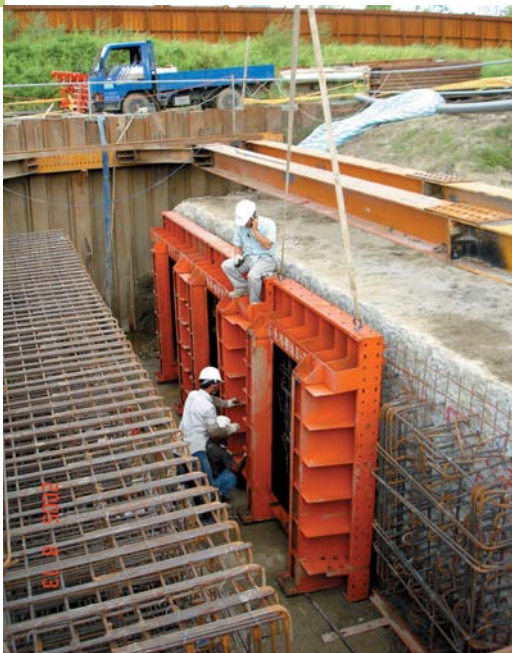
高鐵減振工程基礎加勁構造錨錠塊鋼模安裝。
