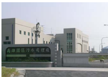
高雄園區各項基礎建設均已完備，圖為污水處理廠。
