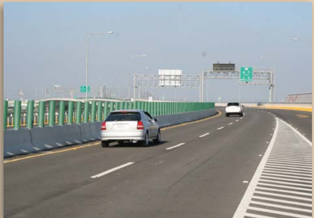
高雄園區銜接中山高聯絡道工程獲第8屆公共工程金質獎。
