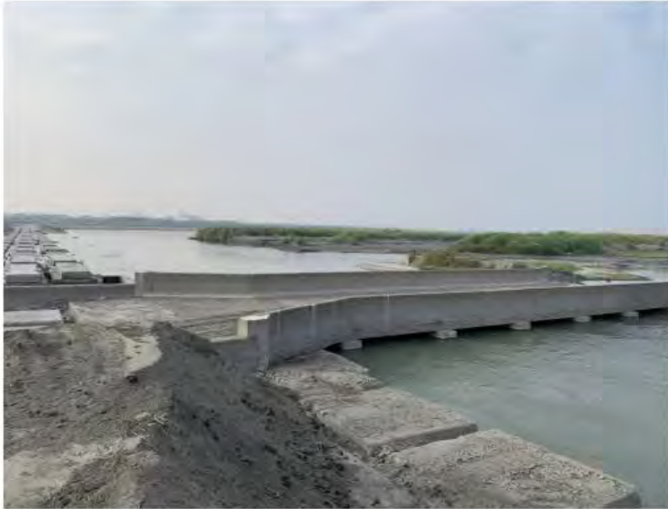
附圖 5、導水設施(污水渡槽)近照
