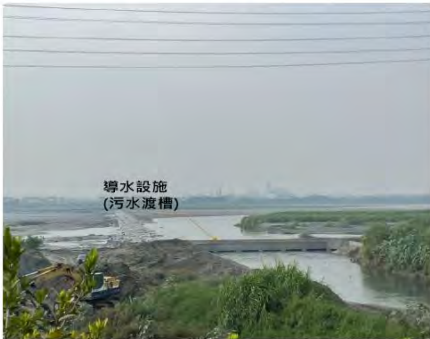
附圖 4、導水設施(污水渡槽)
