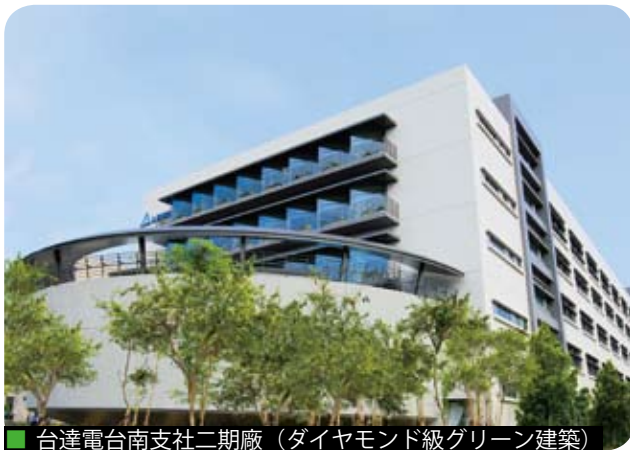
■ 台達電台南支社二期廠（ダイヤモンド級グリーン建築）
