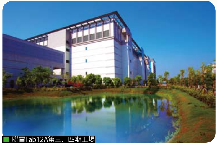
■ 聯電Fab12A第三、四期工場
