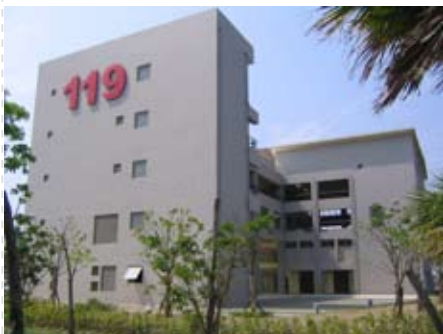
▲台南園区の消防隊舎、園区内の安全は更に保障されている
