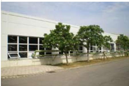
▲汚水処理場の曝気槽施蓋工事完了後の外観
