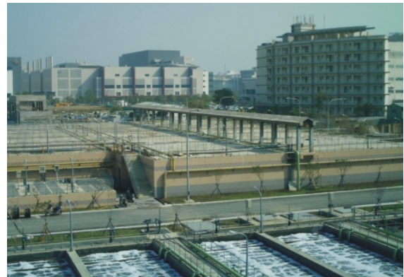
台南園区汚水処理工場二期工事
