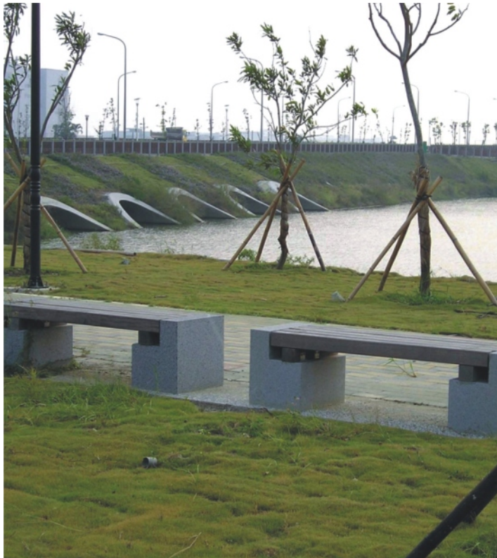
新しく建設された40メートル道路下の五孔排水管は南北両側の遊水池を接続している
