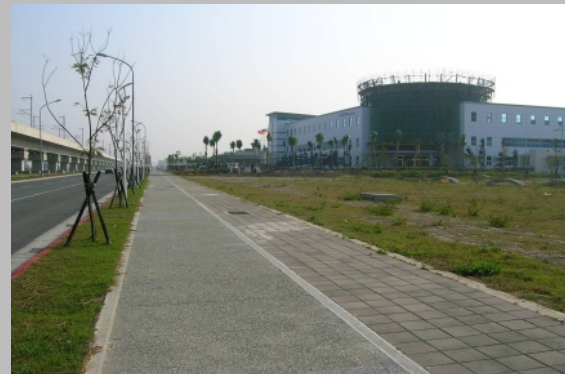
弾力性振動吸収壁工事完了後の現場(歩道右側下方地層に施工、上方はすでに復旧作業完成)
