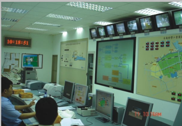
洪水防止制御センターは24時間園區内の大洲水位及び雨量を把握
