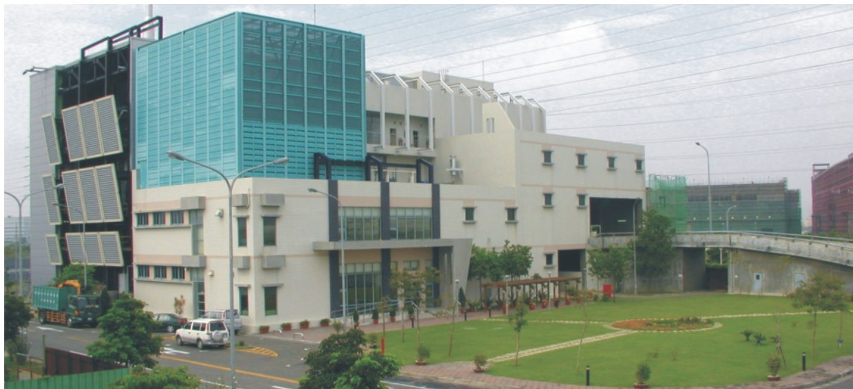
台南園区資源リサイクルセンター
