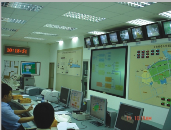
防汛監控中心24小時監控園區大洲水位及雨量
