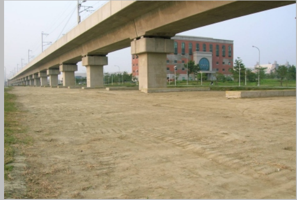
基礎加勁構造完工後現地(施作於高鐵橋墩間之地下結構，地面突起處為減振连接器維修人孔)
