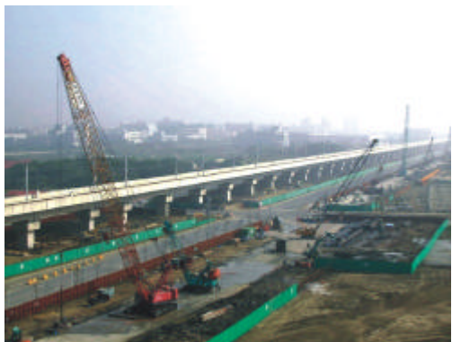
彈性減振牆施工情形
