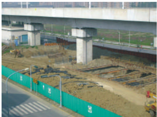
基礎加勁構造施工情形
