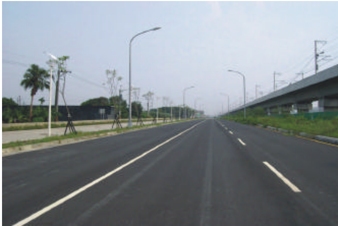
北側住宅區及東一東二區開發工程(東二區道路)
