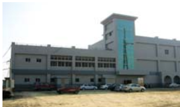
圖 5-6-14 路竹園區台電超高压變電所 (2004年6月完成予定)
