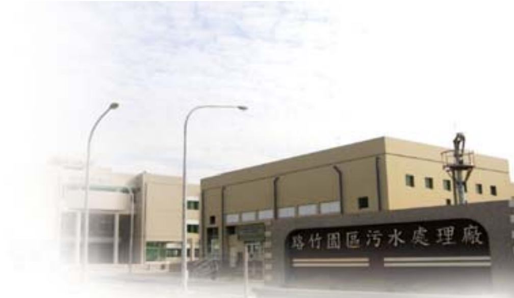
圖 5-6-8 路竹園區污水處理廠第一期工程
