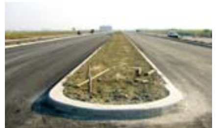
圖 5-6-12 路竹園區一期一区道路工程
