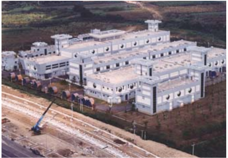
图 5-4-3 台南園區南科超高压变電所
