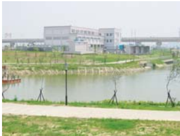
図 2-9 洪水防止排水ステーション
