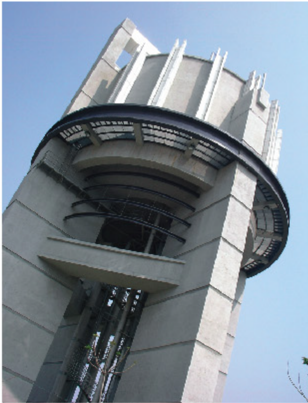
> 第二基目貯水タンク
