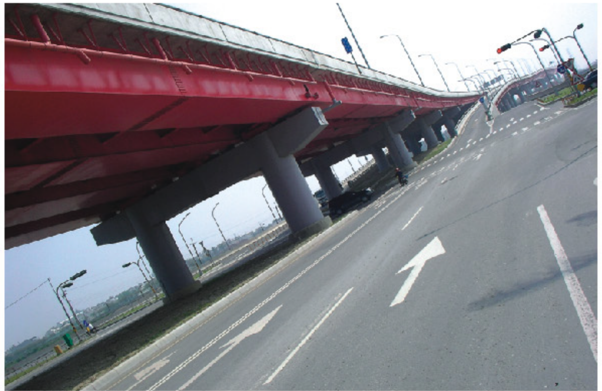
> 南側外環道路
