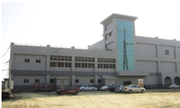
圖 5-6-14 路竹園區台電超高壓變電所(九十三年六月完工)
