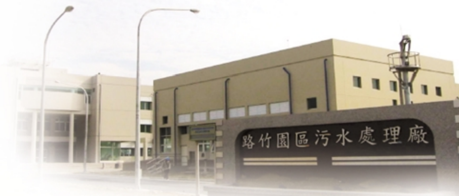
圖 5-6-8 路竹園區污水處理廠第一期工程
