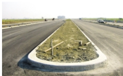
圖 5-6-12 路竹園區一期一區道路工程
