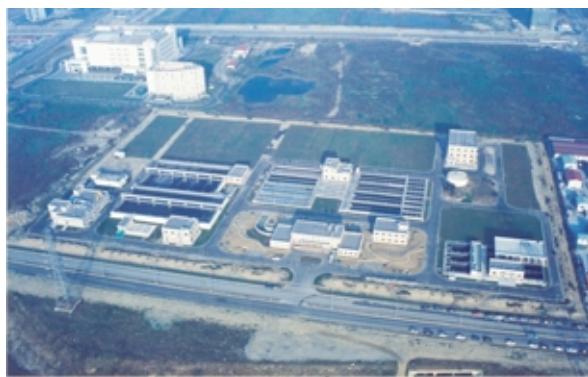
圖 5-3-1 環工中心（污水處理廠）
